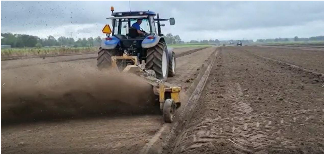
Afb. 2 : Aanleg greppel plas-dras
